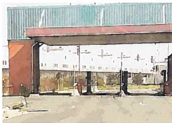
Uno degli ingressi dell'interporto di Guasticce
